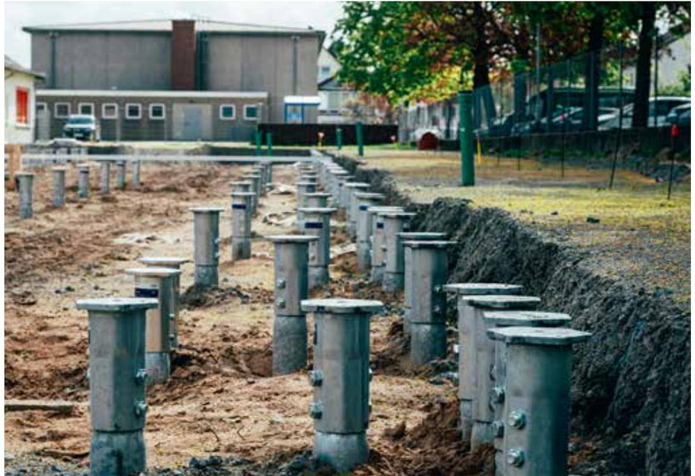
Der zeitliche und organisatorische Ablauf des Großprojektes in Münster war optimal. Wegen der dichten Bodenstruktur konnte auf eine Schraubfundament-Verlängerung verzichtet werden. Die Baustelle wurde während des laufenden Schulbetriebes geführt, was dank des Verzichtes auf Beton-Fundamente möglich war. Die Montage von Schraubfundamenten stellt keine Lärmbelästigung dar und ist innerhalb kürzester Zeit abgeschlossen.
